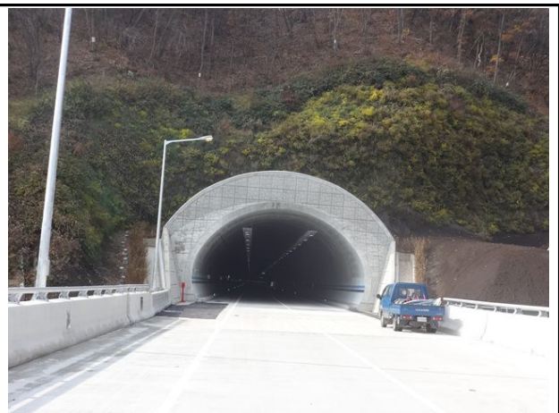
갱문 종점부 전경
