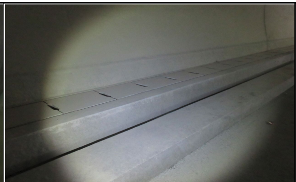
지정3터널 공동구 시공상태 점검(원주방향)
