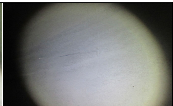
지정3터널 횡갱 라이닝 시공 상태 점검
