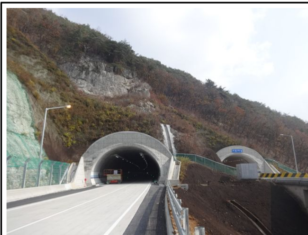
시점측 터널부사면 전경
