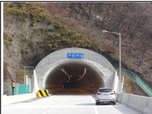
갱문 시점부 전경
