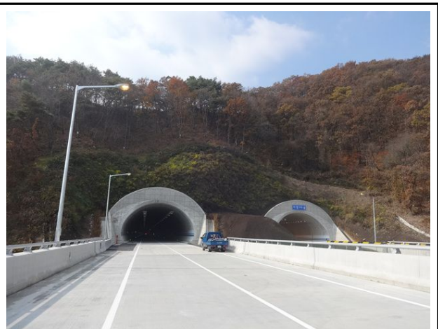
종점측 터널부사면 전경
