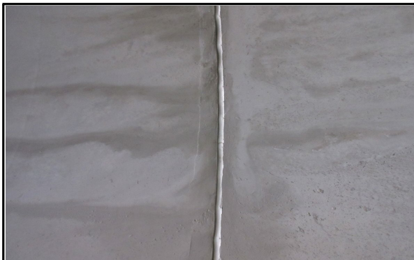
지정3터널 JOINT 시공 상태 점검(원주방향)
