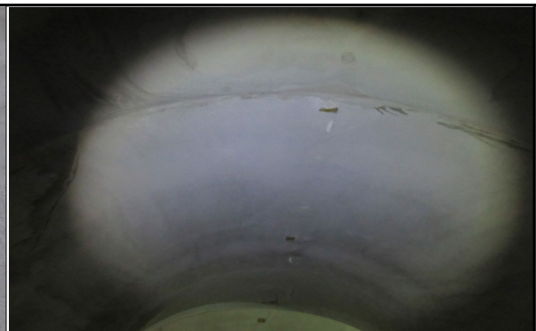
지정3터널 천정부 시공 상태 점검(원주방향)
