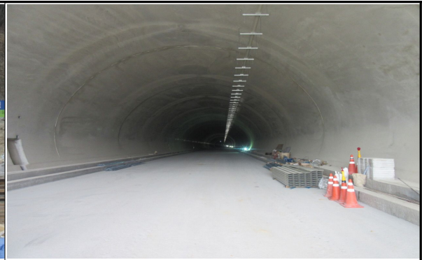
지정3터널 내부 전경(원주방향)
