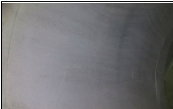
지정3터널 라이닝 시공 상태 점검(원주방향)
