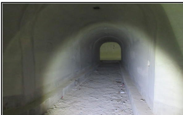
지정3터널 횡갱 전경
